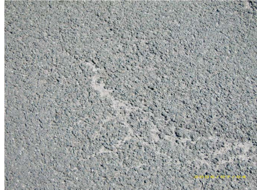
Ausgemergelte Fahrbahndecke
