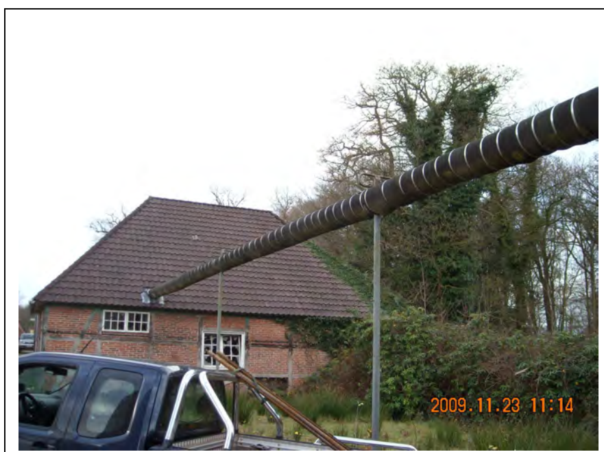
Bild 20: Versorgungsrohre mit KMF-Ummantelung
