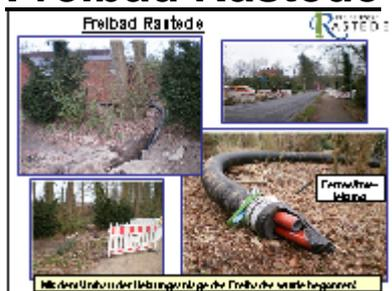
Wie aus Presse bekannt wurde mit dem Umbau der Heizungsanlage im Freibad vor einigen Wochen begonnen. Die alten Heizungsanlagen wurde mittlerweile demontiert und die Fernwärmeleitung der Biogasanlage installiert.
