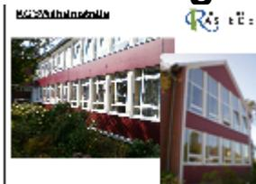
An der KGS Wilhelmstraße wurden ebenfalls umfangreiche energetische Sanierungen in den Sommerferien durchgeführt. So wurde die Ostfassade saniert, Fensterelemente ausgetauscht und teilweise Geschossdecken nachgedämmt. Außerdem wurde eine Hohlraumdämmung durchgeführt. Hierfür wurden insgesamt ca. 145.000,-- € aufgewendet.
