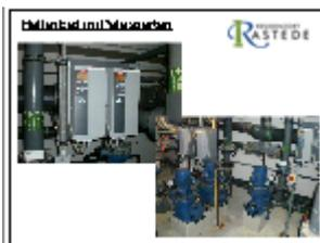
Im Rahmen der Umsetzung des Energiekonzeptes und Maßnahmenhandbuches der Gemeinde Rastede wurde vor Beginn der Saison der Einbau von Frequenzumformern für die Umwälzpumpen abgeschlossen.
