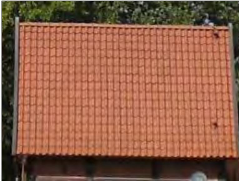
Abb.: Hohlziegel (Tonpfanne – rot) als typisches Material
