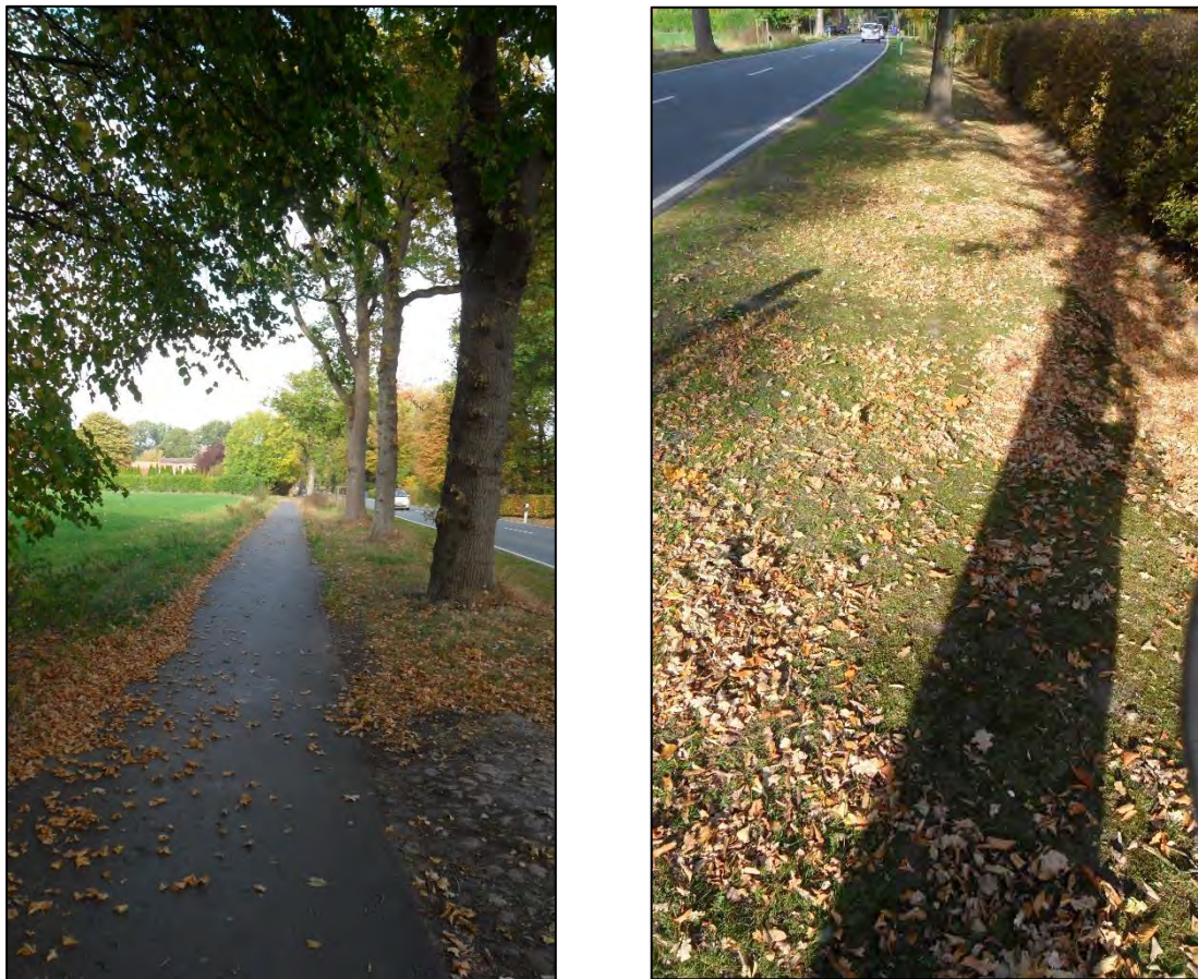
Abbildung 6: Parallel verlaufender Fuß- und Radweg mit markantem Baumbestand im Bermenbereich (Westseite) sowie als Scherrasenfläche genutzte Straßenberme auf der Ostseite der Butjadinger Straße (Quelle: Verfasser, Oktober 2018).
