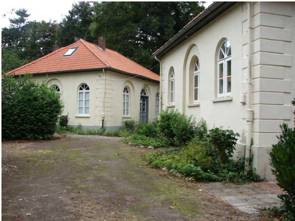
Torhäuser von Norden
