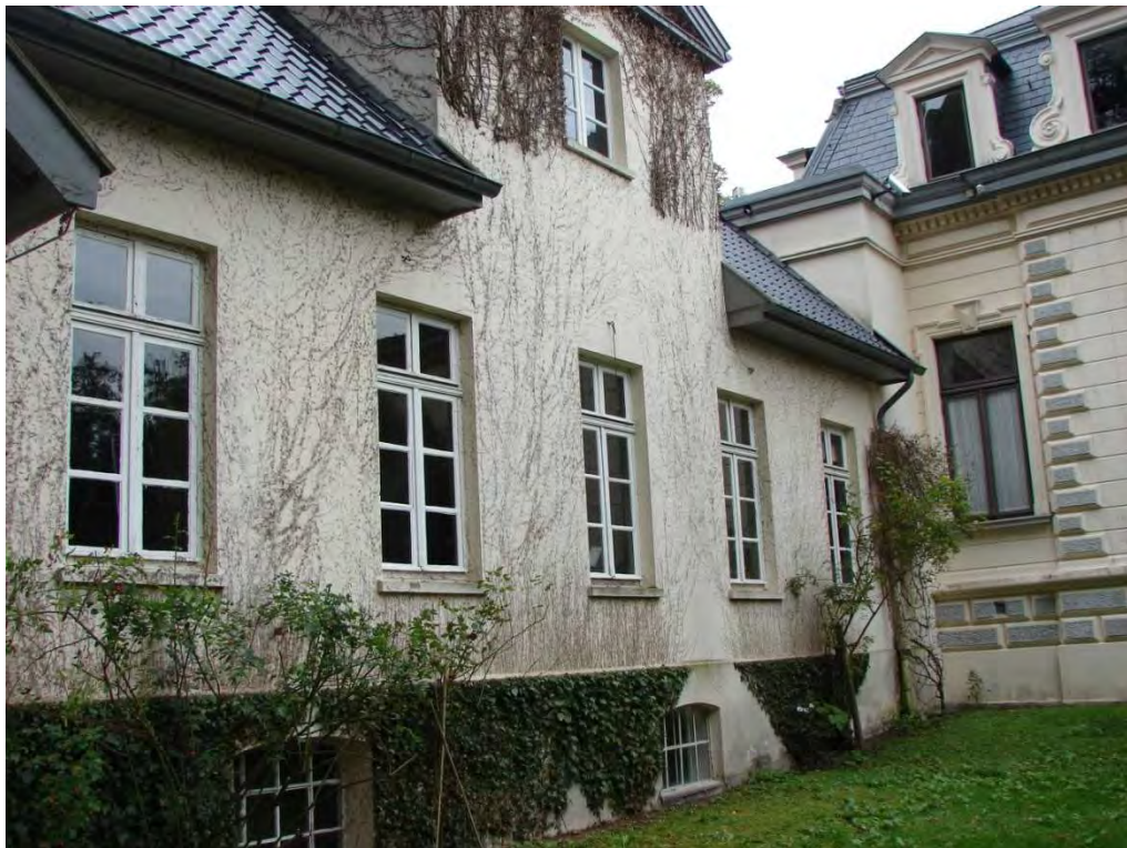
Anbau an der Ostseite
