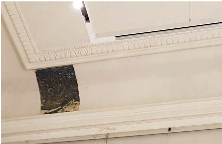
Erdgeschoß Innenraum– sorgfältig restaurierte Räumigkeiten mit großem Potential an Ergänzungen im Bereich der Restauratorarbeiten
