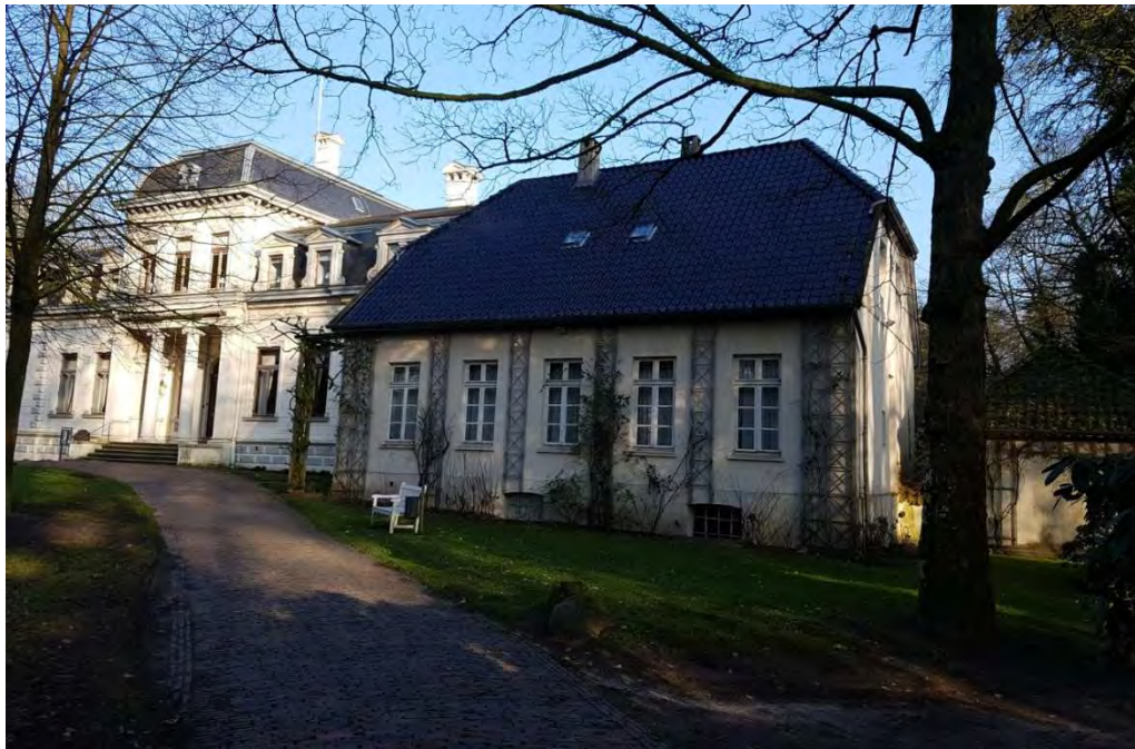
Nebengebäude – der bedeutende Bestandteil des baulichen Komplexes und gleichzeitig die ältesten Gebäude der Anlage
