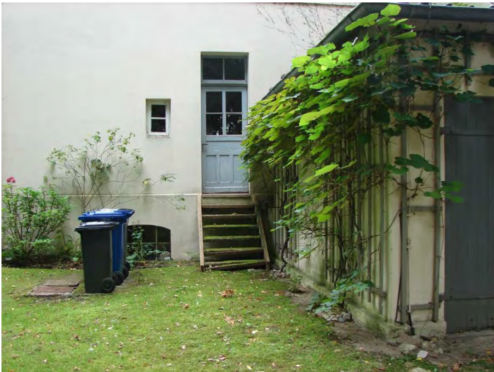
Zugängigkeit des Anbaus aus den Freiflächen – Südeingang und Wirtschaftseingang auf der Nordseite
