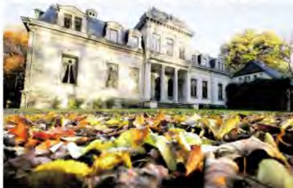
National bedeutsames Kulturgut: Die Instandsetzung und Umgestaltung des Palais Rastede wird vom Bund mit 1,44 Millionen Euro gefördert. Das beschränkt am Donnerstag der Haushaltsausschuss des Bundestages.
