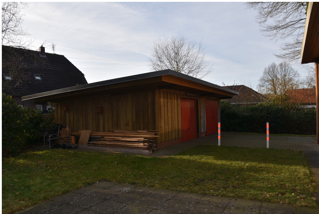
Abb. 7.3-27: OF Loy-Barghorn: Doppelgarage zur Lagerung der Ausrüstung
