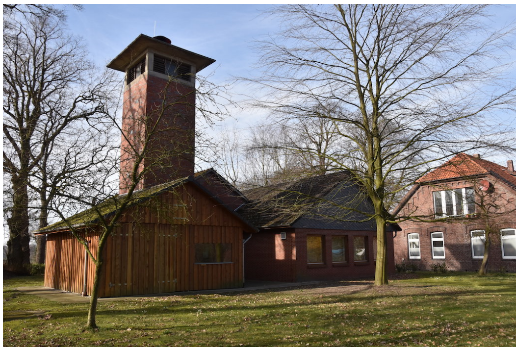
Abb. 7.3-34: OF Neusüdende: Holzanbau hinter dem Feuerwehrhaus
