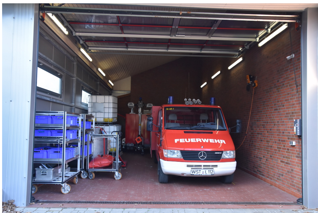
Abb. 7.3-4: OF Rastede: Angebaute Kalthalle
