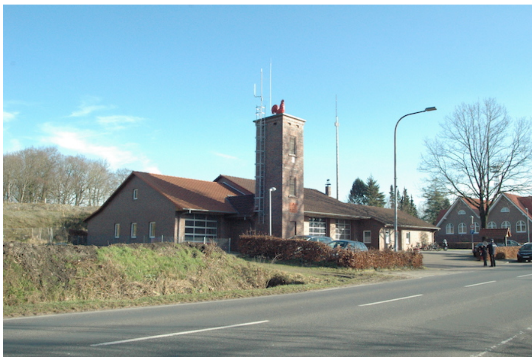
Abb. 7.3-11: OF Hahn: Feuerwehrhaus
