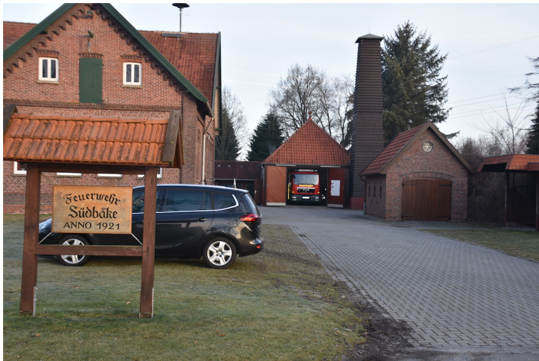
Abb. 7.3-39: OF Südbäke: Feuerwehrhaus (Ausfahrtansicht)
