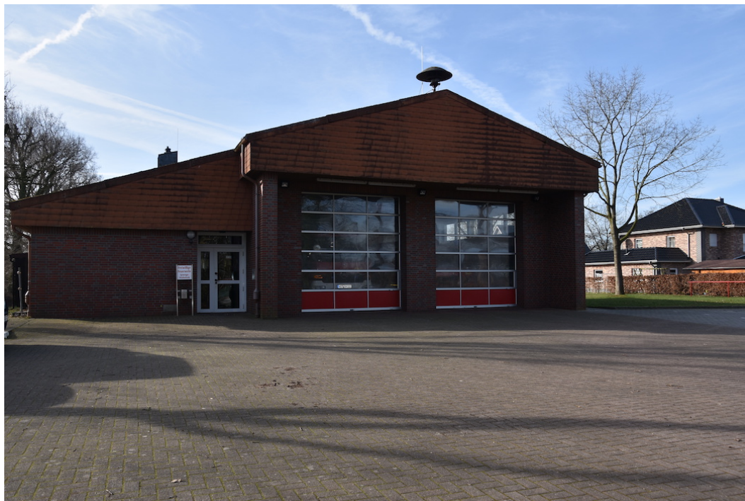
Abb. 7.3-17: OF Ipwege-Wahnbek: Feuerwehrhaus mit Alarmparkplätzen
