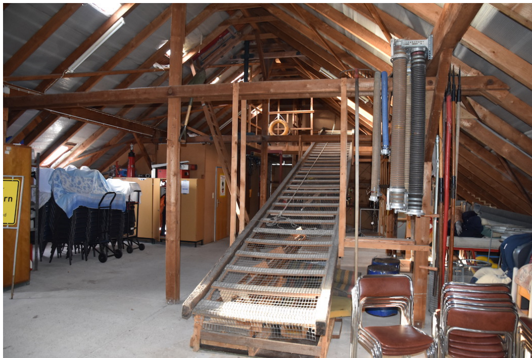
Abb. 7.3-24: OF Loy-Barghorn: Lager auf dem Dachboden
