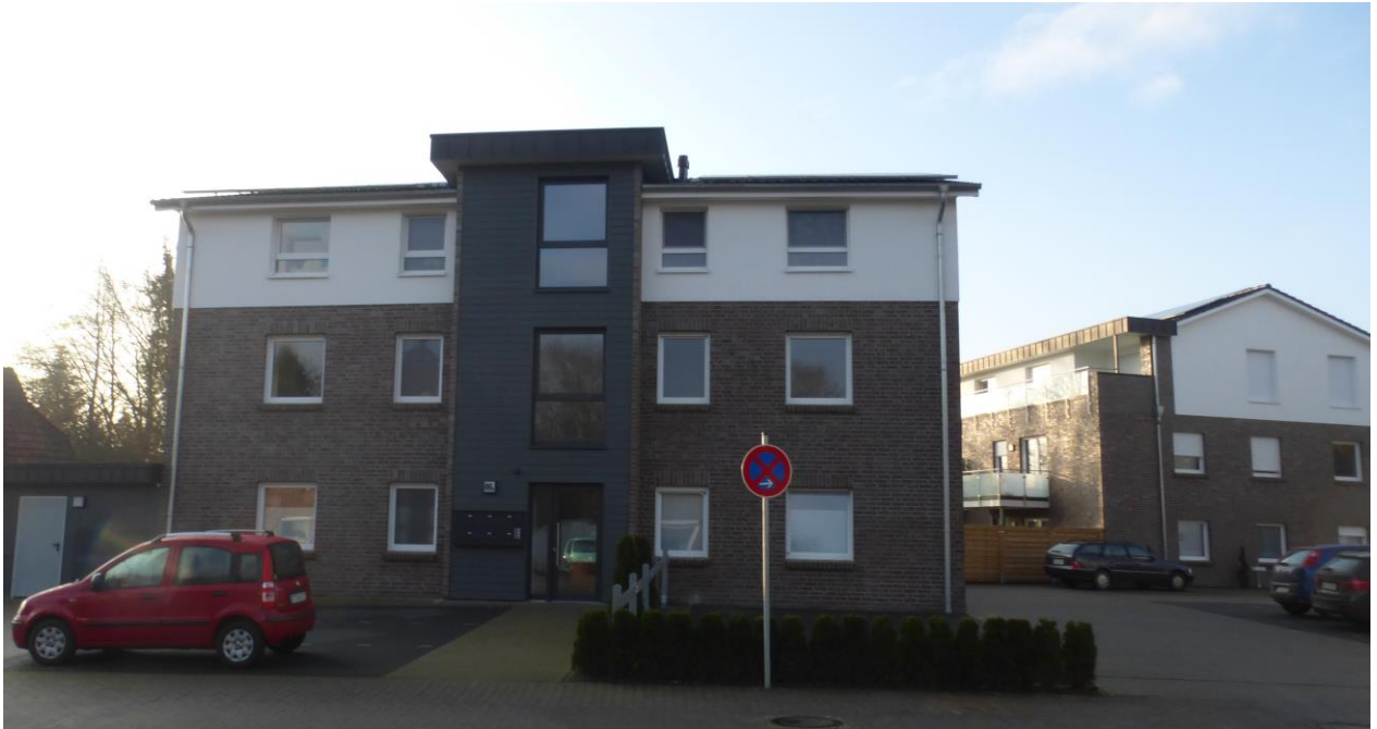
Änderungsbereich 2, südlich der Schulstraße, Kreuzungsbereich Schulstraße
