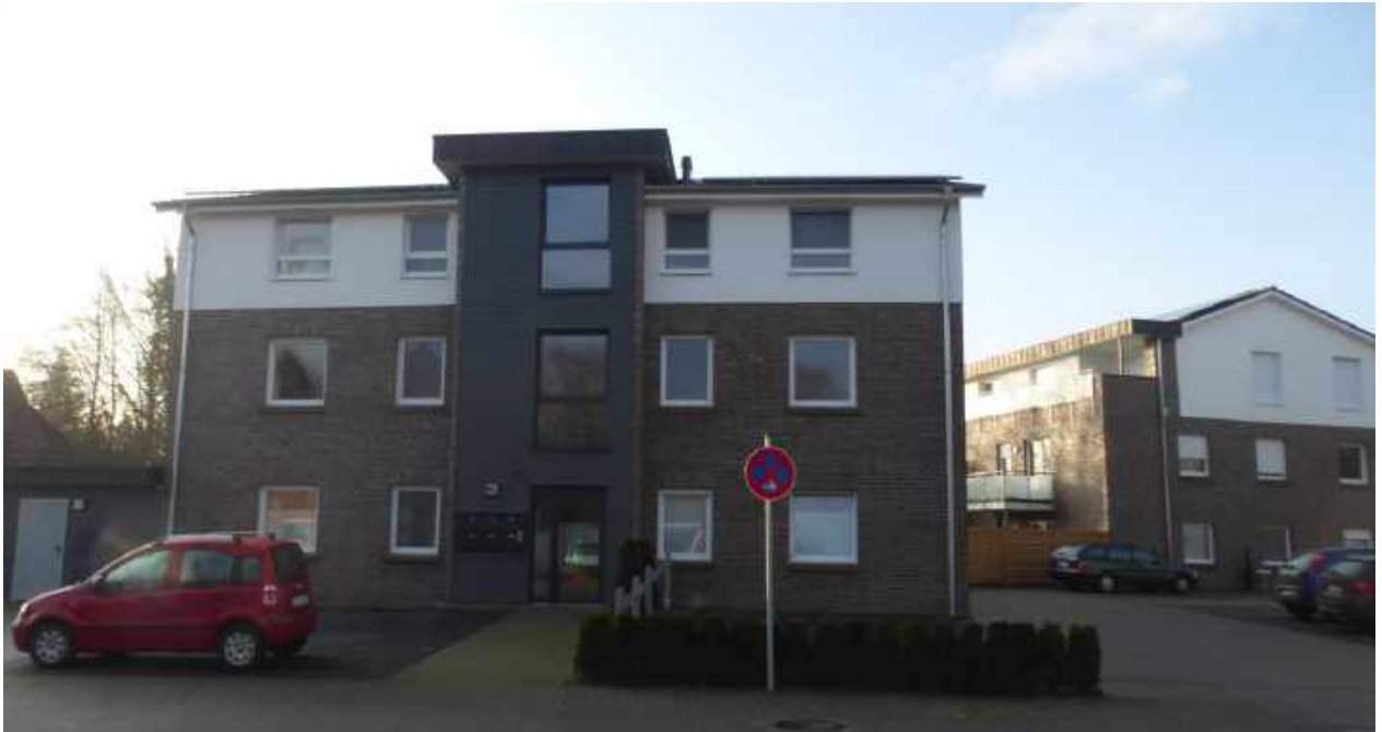
Änderungsbereich 2, südlich der Schulstraße, Kreuzungsbereich Schulstraße
