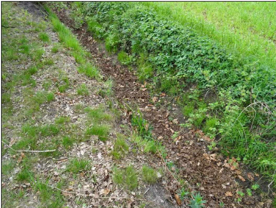
Foto 2: Trockener Graben mit halbruderaler Vegetation im Böschungsbereich
