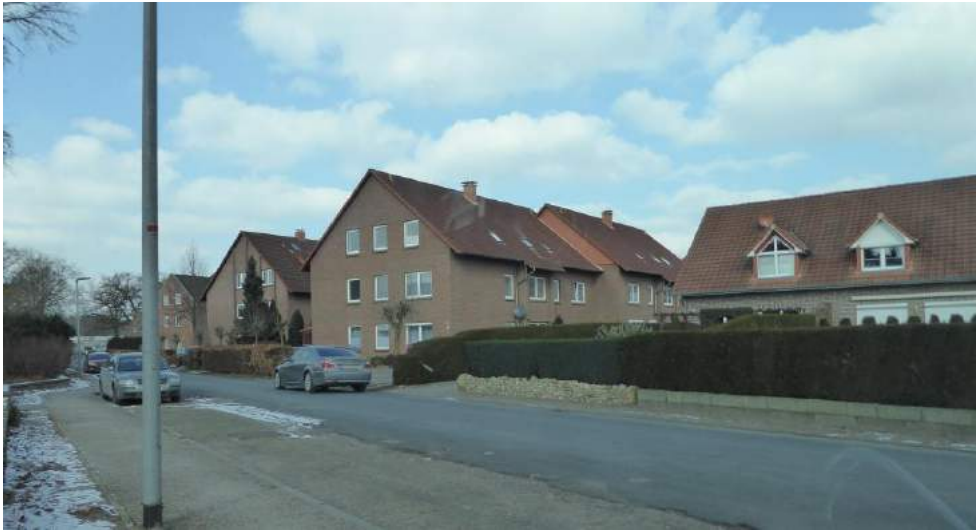
Südlicher Geltungsbereich; Blick von der Havelstraße in Richtung Westen
