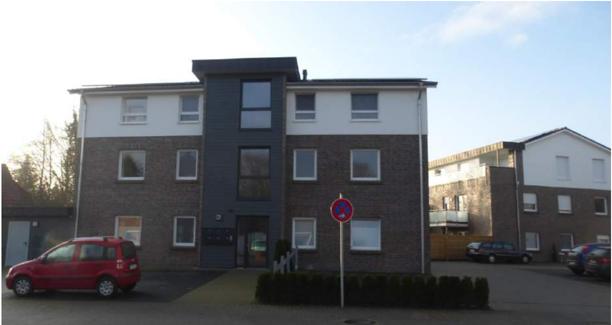
Änderungsbereich 2, südlich der Schulstraße, Kreuzungsbereich Schulstraße
