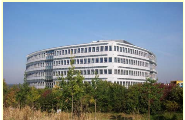
Das könnte ein Beispiel für die energiegerechte Bebauung sein: das größte Passivhaus - Bürogebäude „ENERGON“ in Ulm (Foto: ebök)
