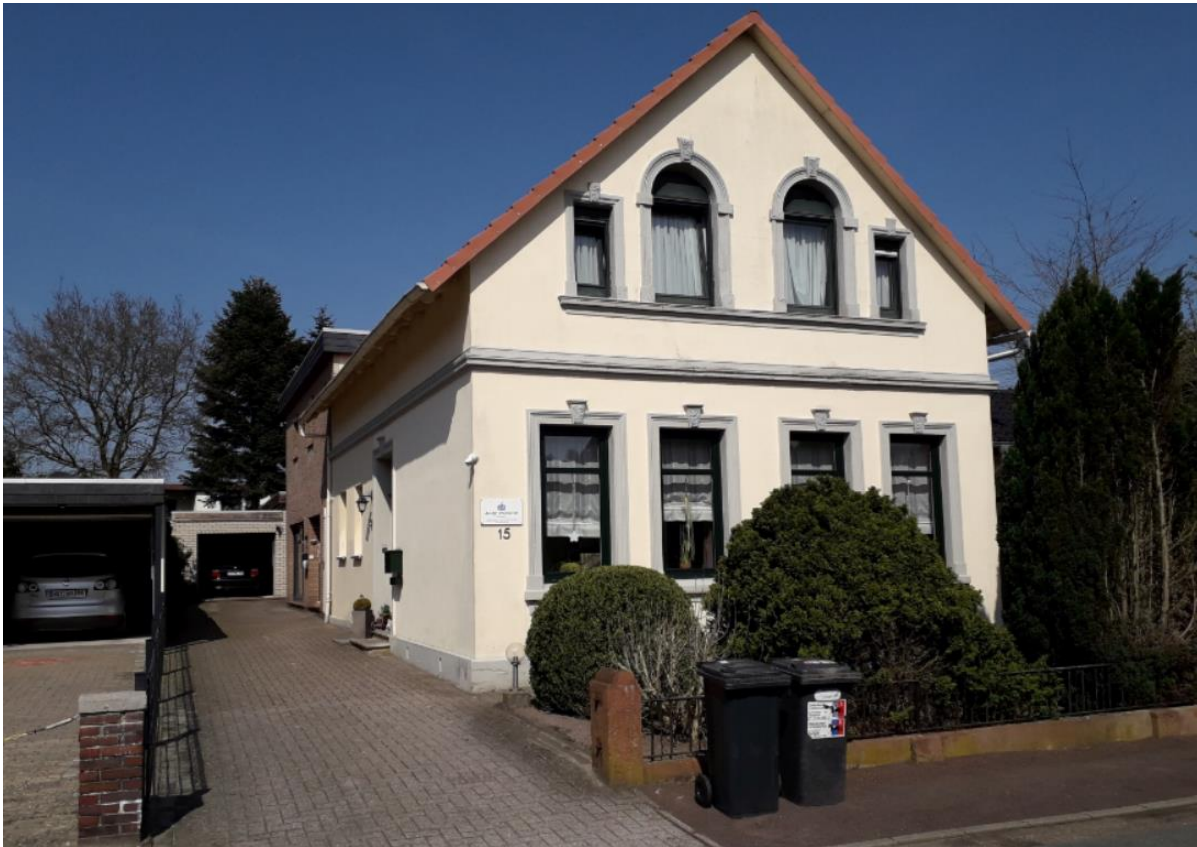
Nördliche Seite der Friedrichstraße Nr. 15 mit rückwärtigem zweigeschossigen Anbau
