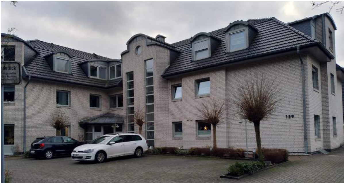
Mehrfamilienhaus Oldenburger Straße Ecke Lindenstraße
