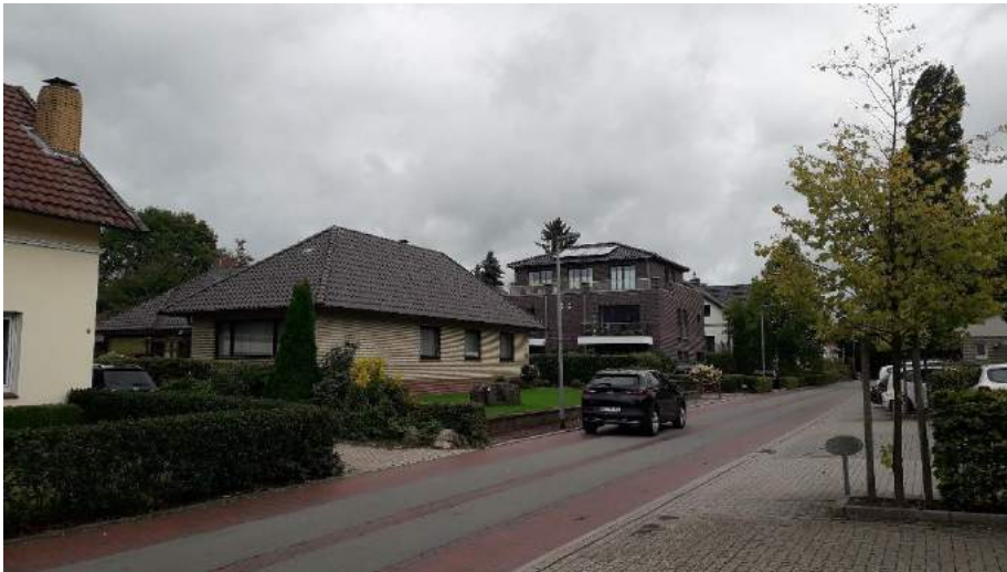
Peterstraße Blick Richtung Norden (Gebäude außerhalb des Geltungsbereiches der 9. Änderung)
