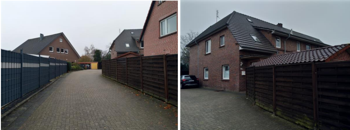
rückwärtige Bebauung im nördlichen Geltungsbereich
