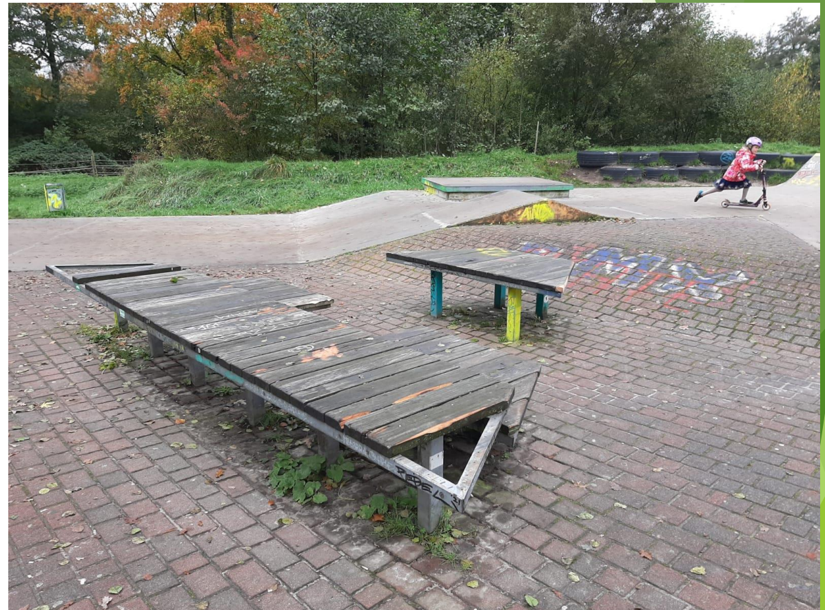
Gepflasterte Fläche & zerfallene Sitzbänke
