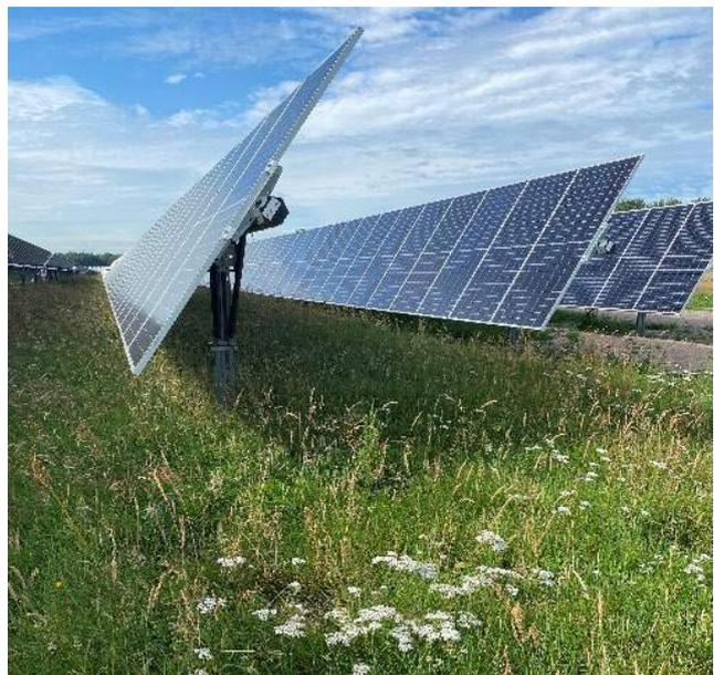
Abbildung 2: Nachgeführte Solarmodule Solarpark Lottorf
